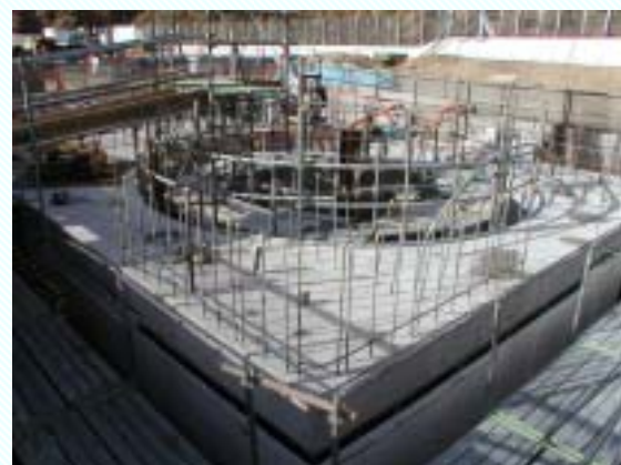
主立坑の坑口の基礎工事の様子
