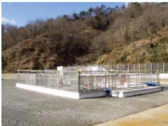
換気立坑の坑口部の様子
